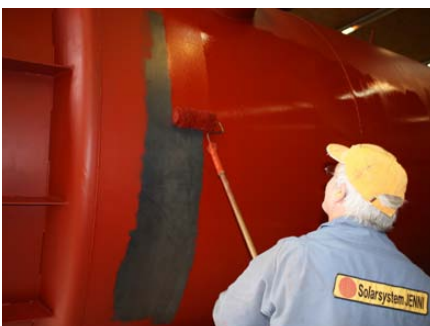
Attaching the anti-rust primer
