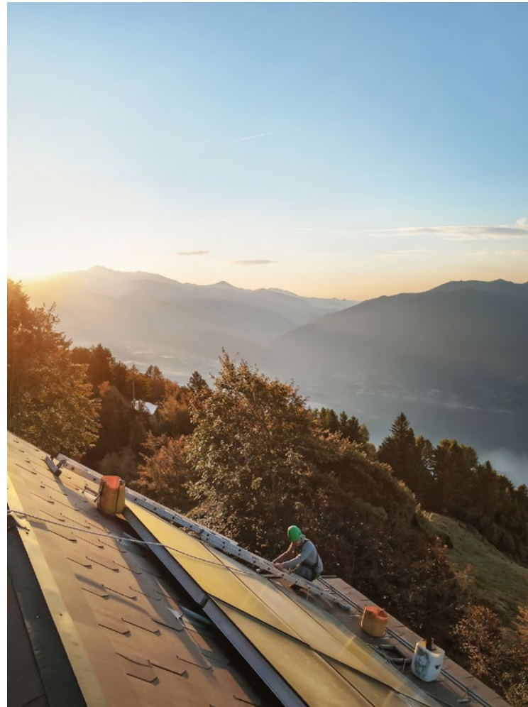
Immer näher an der Sonne: Benvenuto Ticino! Unser Mitarbeiter Miro Luginbühl ist seit April 2023 in unserer neuen Zweigstelle Tessin tätig, hier bei einer Servicearbeit vorschriftsgemäss gesichert.
