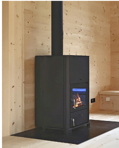
Stückholzofen als Ergänzung zur Solarwärme: Im EFH Bätterkinder reichen 1 – 1.5 Ster Brennholz pro Winter, um den Restbedarf an Wärme zu decken.
