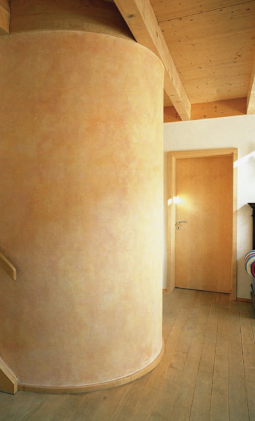
Der Pufferspeicher verteilt die Sonnenenergie im ganzen Haus.
