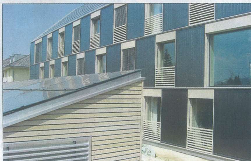
In die Fassade integrierte Module: Die Kollektoren sind über das ganze Haus verteilt.
