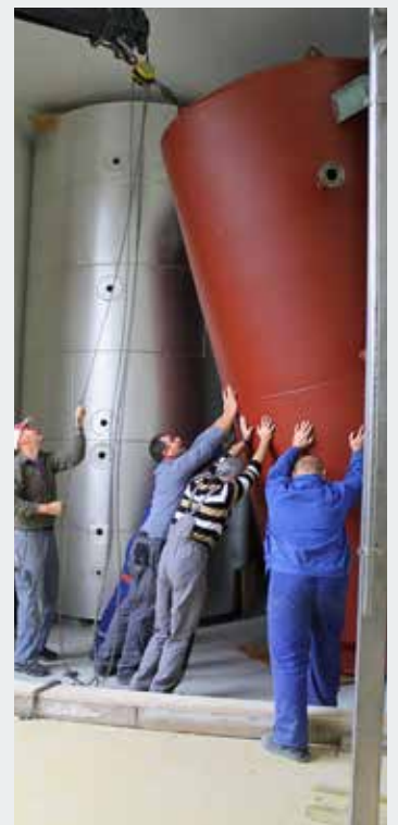
Lieferung des Speichers. Livraison de l'accumulateur.
