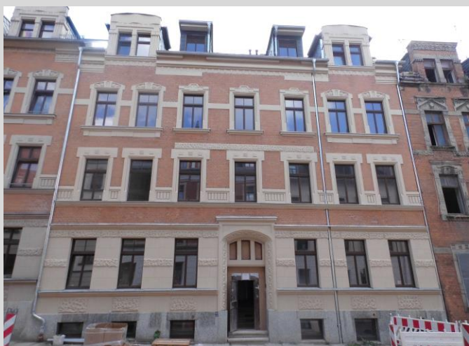
Straßenansicht nach Sanierung: Kanalstraße 15, 09113 Chemnitz Quelle: FASA AG
