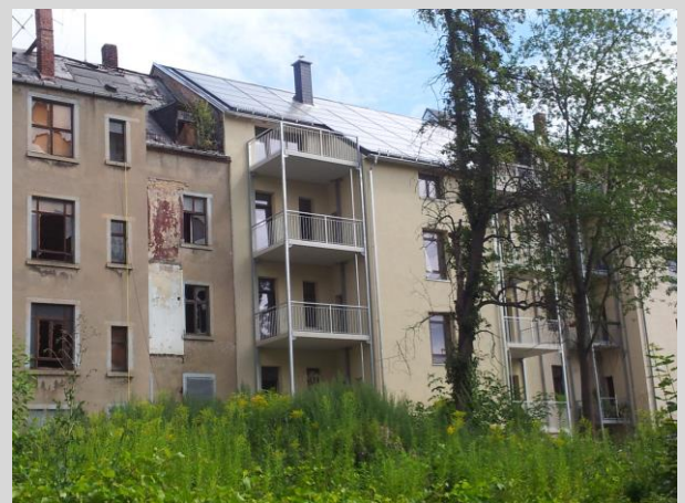
Rückansicht Kanalstraße 15 nach Sanierung
