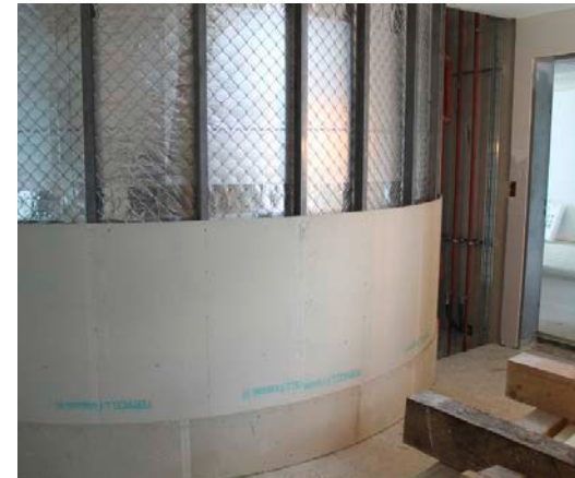
Fertig montierter und perfekt isolierter Wärmespeicher «Swiss Solartank»
