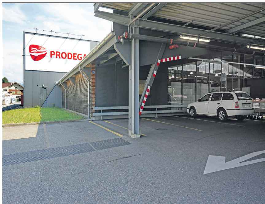
In diesem Einstellhallenteil soll die erweiterte Ladenfläche gebaut werden. Max Sterchi
