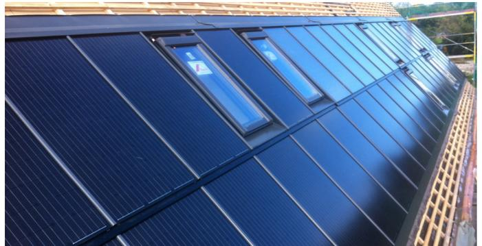
Grossflächenkollektoren für Thermie und Photovoltaik gibt es in verschiedenen Standardmassen. Sondermasse und Schrägen, bei welchen die Module bis in den Randbereich voll funktionsfähig sind, werden individuell auf Ihre Bedürfnisse gefertigt.
