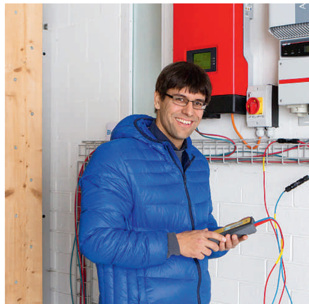
Michael Sattler vom Ökozentrum Langenbruck (hier bei der Kontrolle der Generatorkennlinien der institutseigenen Photovoltaik-Anlagen) ist Autor der Studie zum Technologievergleich rund um die solare Warmwassererwärmung. (Foto: Ökozentrum)
