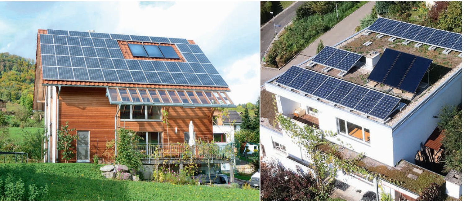
Regelmässig werden Gebäude mit bestehender Solarthermie-Anlage zusätzlich mit Photovoltaik ausgerüstet. Bei der heutigen Fördersituation fällt der Entscheid, welche Technologie für die Sonnenenergienutzung verwendet werden soll, oft zugunsten der Photovoltaik aus. (Fotos: Ökozentrum)
