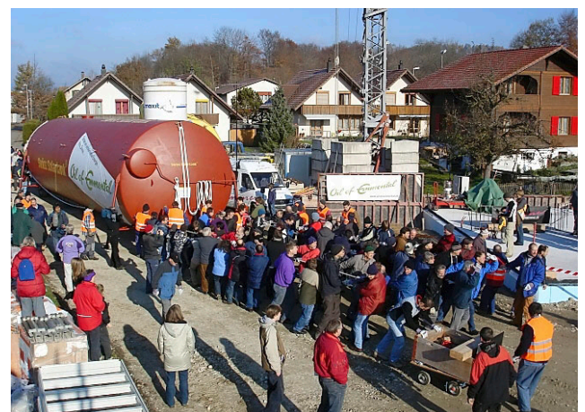
Die Energiewende fand in Oberburg bereits 2005 statt, als die Mitarbeitenden des Unternehmens den Solarspeicher von Hand zur Baustelle zogen. (Bild: Jenni AG)
