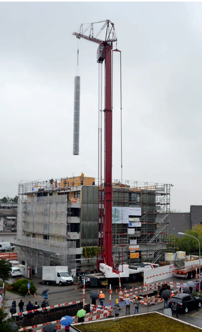
Wasser-Wärmespeicher: 19 m lang, Durchmesser 110 cm, Inhalt 17 600 Liter. (Foto: Jenni Energietechnik)
