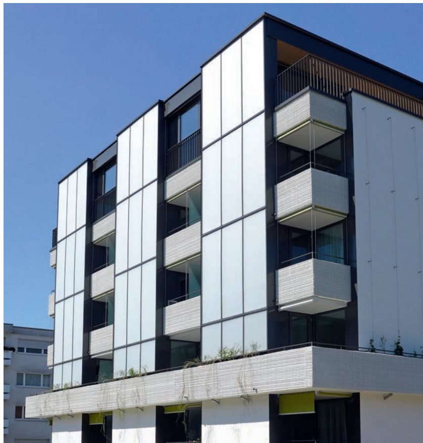
Südfassade des modernisierten MFH an der Stettbachstrasse 43 in Zürich-Schwamendingen.
