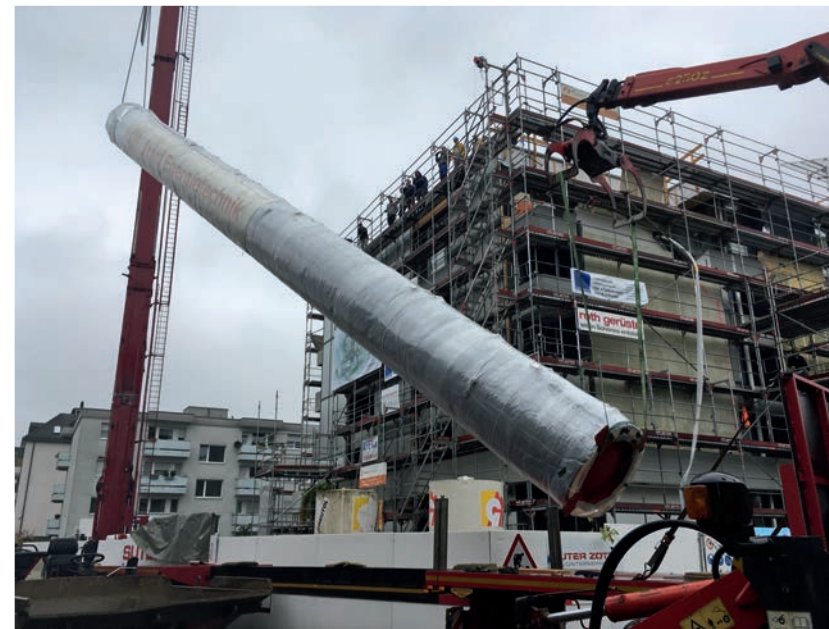
Präzisionsarbeit mit Kran: Einbringung des Jenni-Speichers am 26. Oktober 2016 in den zentralen ehemaligen Lüftungsschacht. (Fotos: kämpfen für architektur ag / Peter Warthmann)
