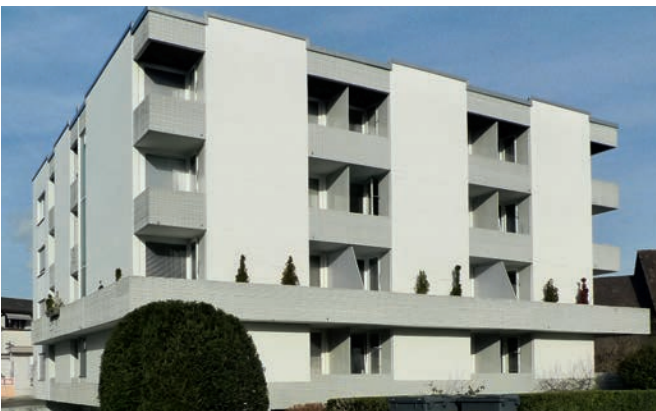
Das Mehrfamilienhaus vor dem Umbau. (Fotos: kämpfen für architektur ag)
