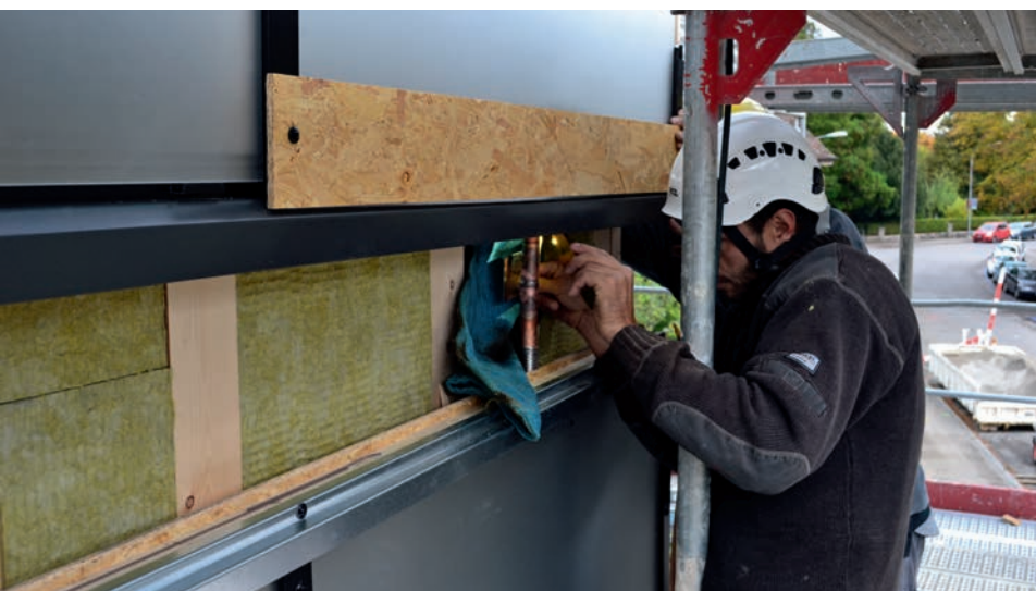
Montage der Kollektoren an der Fassade.
