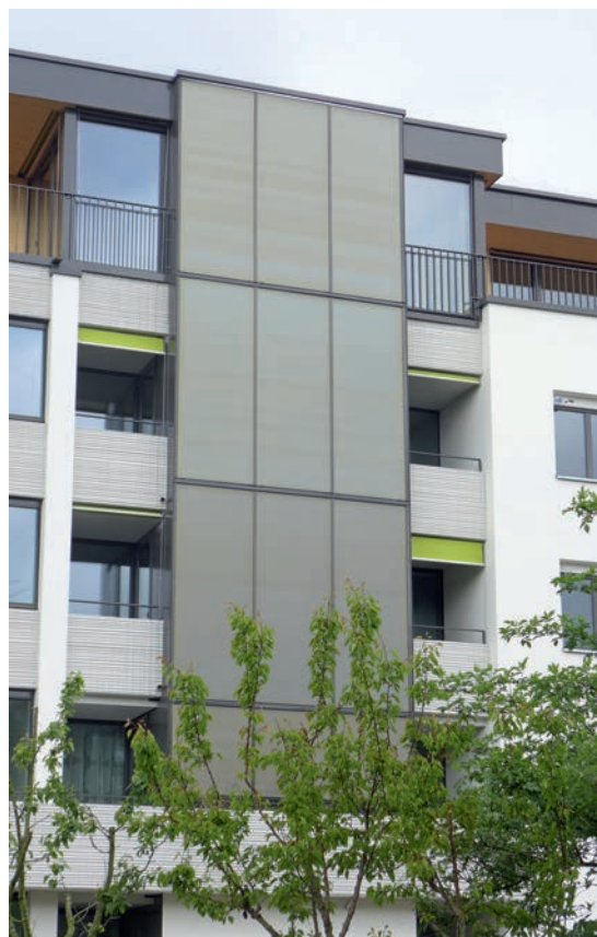
Sonnenkollektoren an der Ostfassade: Abhängig von Tageszeit und Wetter ändern sich die Farben.
