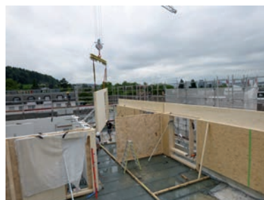
Neues Attikageschoss: Aufstockung in Holz mit vier neuen Wohnungen.
