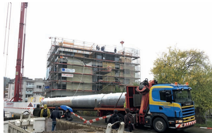
Präzisionsarbeit mit Kran: Einbringung des Jenni-Speichers am 26. Oktober 2016 in den zentralen ehemaligen Lüftungsschacht. (Fotos: kämpfen für architektur ag / Peter Warthmann)
