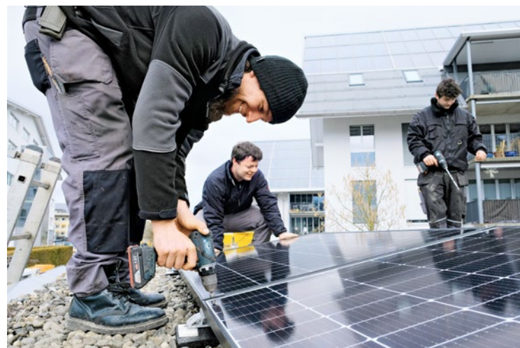
Montage der Photovoltaikanlage Lochbachstrasse 42.
