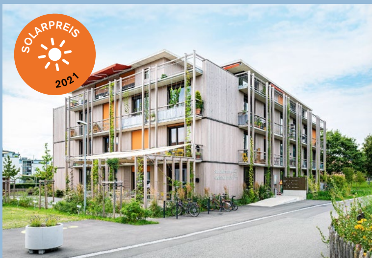
Einen Schweizer Solarpreis gab es auch für das Projekt Stuckimatte in Thun mit 14 Wohnungen, Kita, Atelier und Bistro. Dank Photovoltaik, Solarthermie und Energiespeicher werden über 83 % der benötigten Energie selbst produziert.
