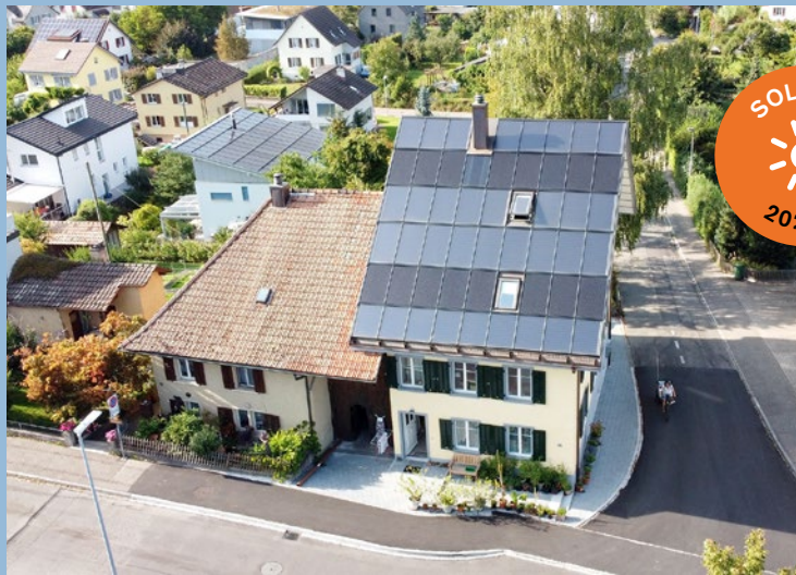
Die Casa Stähli erfüllt die Ziele der Energiestrategie 2050 schon seit 2021.
