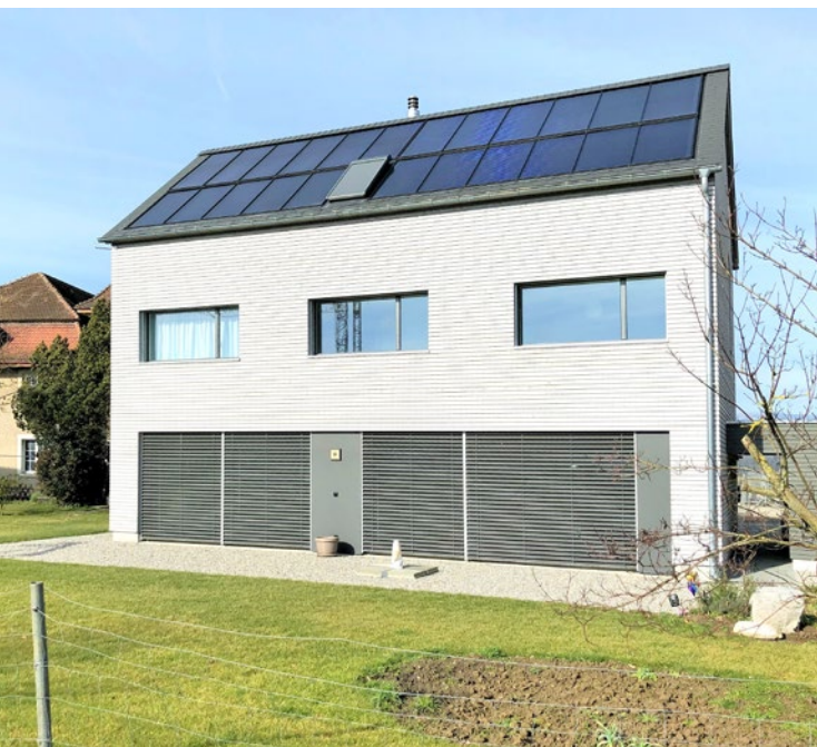
Sonnenhaus in Bätterkinden mit 80 % Deckungsgrad, Nachheizung mit Kaminofen
