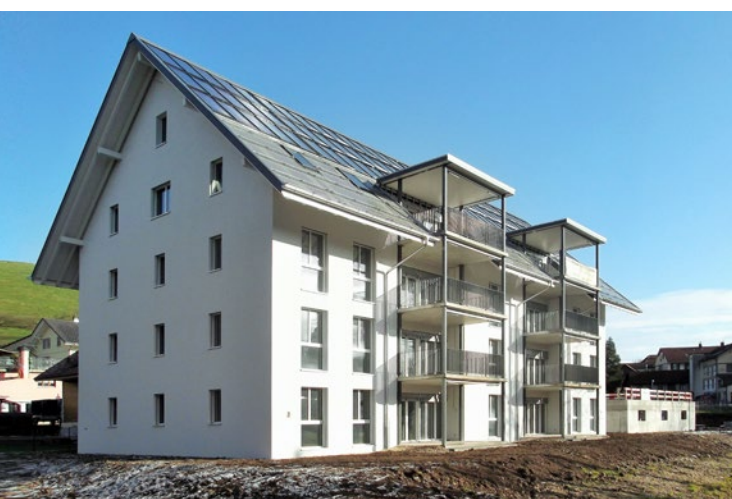
Bald bezugsbereites Solar-Mehrfamilienhaus in Huttwil
