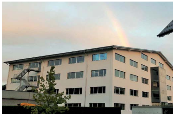
Produktionsgebäude für Grossspeicher mit moderner Produktionsanlage.
