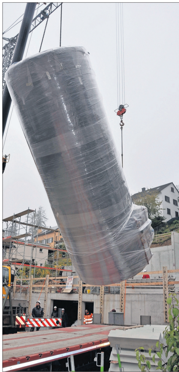
Der riesige Warmwasserspeicher, das «Herz der Solaranlage» am Gütlweg, wurde im Herbst 2016 eingebaut. Bild Ulrich Schweizer
