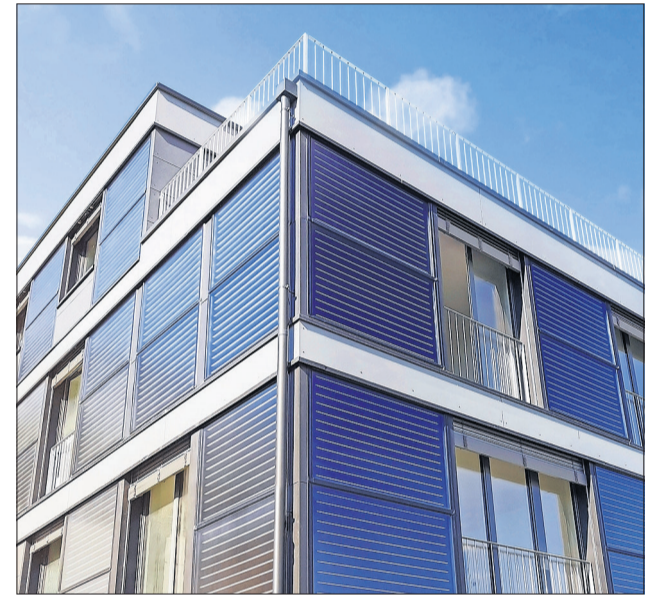
Die Sonnenkollektoren der Südwest- und Südostfassade liefern Warmwasser für die Heizung und zum Duschen. Bild Samuel Gründler
