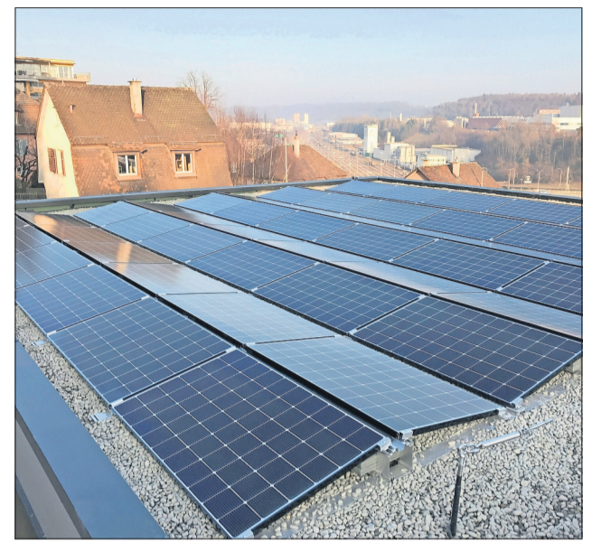
Die Fotovoltaikanlage auf dem Flachdach versorgt das ganze Haus mit Solarstrom. Bild Samuel Gründler
