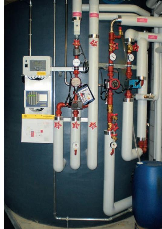
**9400-Liter-Speicher mit allen Installationen und Steuerung für Solar-Warmwasser und -Heizung im EFH Seeberg BE.**
