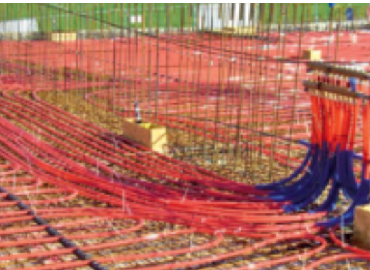
Sichtbare Bauteilaktivierung – viele Rohre auf der Baustelle, hier in Hallwang
