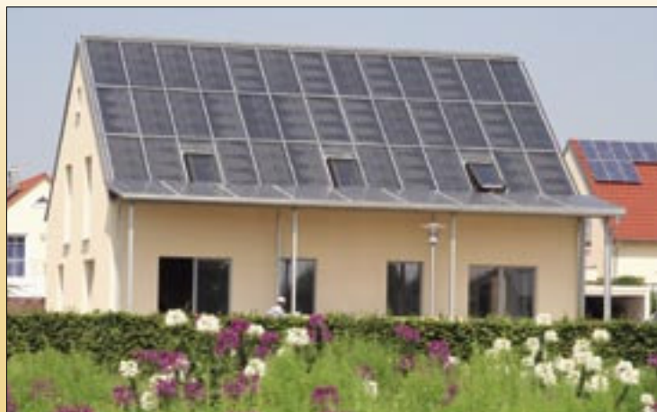
Auch im nebelreichen Regensburg funktioniert ein 100%-Sonnenhaus wie hier das von Jakob Lehner.
