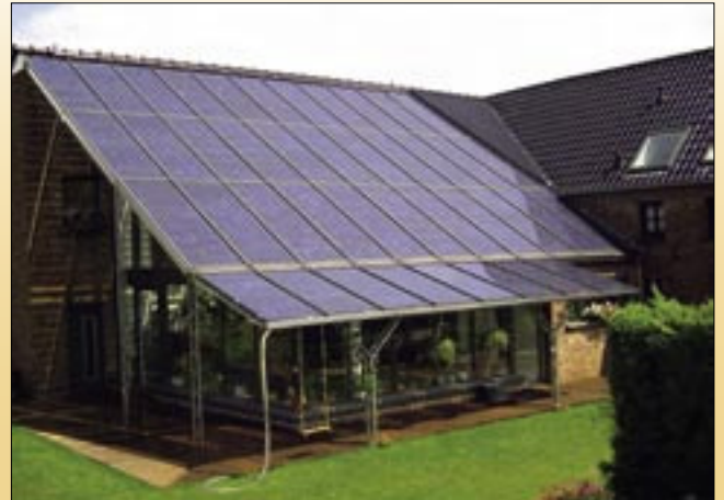
Der rückseitige Anbau des Van-Beeck-Hauses in Kleve bietet Platz für eine große Photovoltaikanlage.
